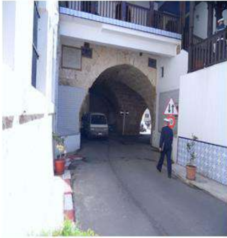
لوحة رقم (04)/ سباط الحوت - المدخل الرئيسي من الجهة الجنوبية.
